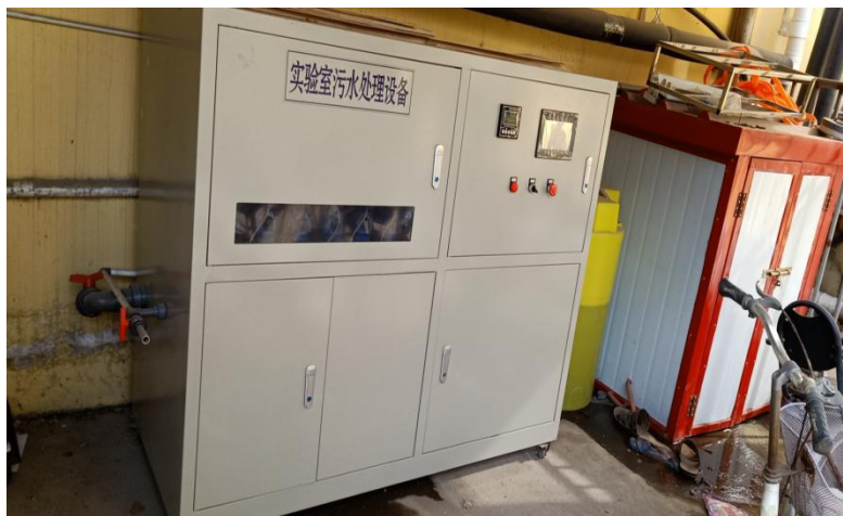
图 6.1-1 实验室污水处理一体机
